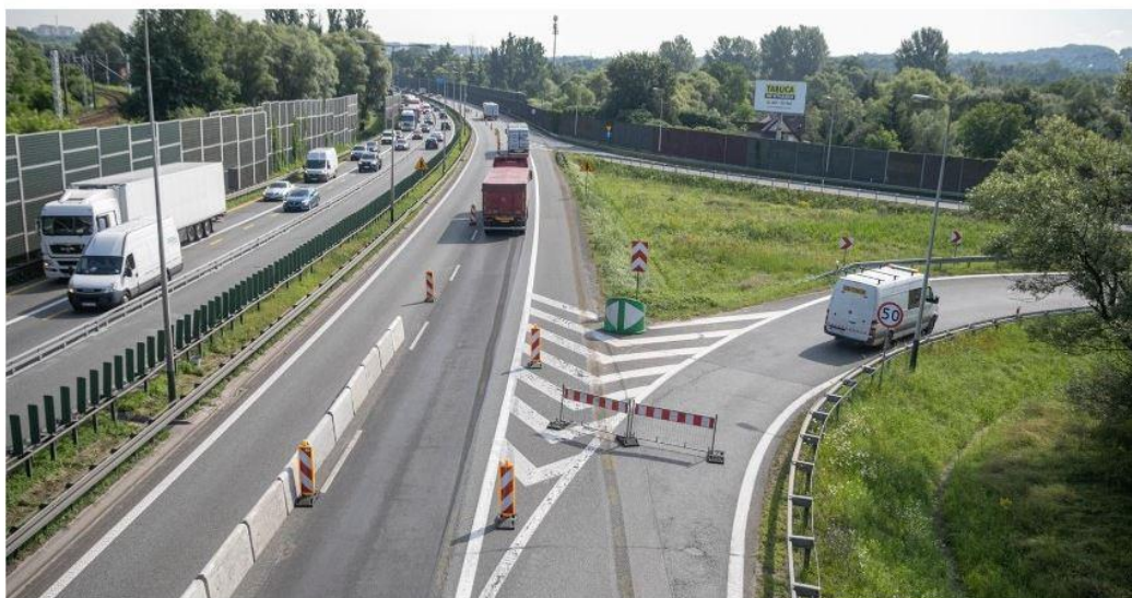
Celem rozbudowy węzła Kraków Południe w Opatkowicach jest poprawa płynności ruchu na węzle drogowym oraz na wylotówce na Chyżne i Zakopane. Anna Kaczmarsz / Dziennik Polski / Polska Press
